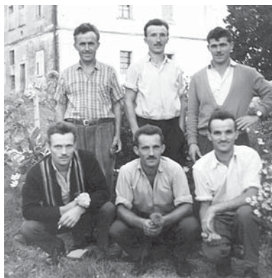
Tržič - Podljubelj 1961. godine. Tominci na gradnji ceste i tunela
