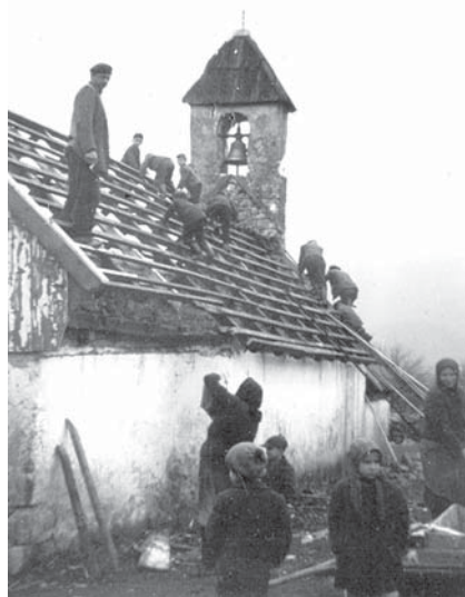
Zamjena krova na kapelici Sv. Petra
