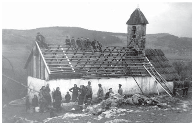
Zamjena krova na kapelici Sv. Petra
